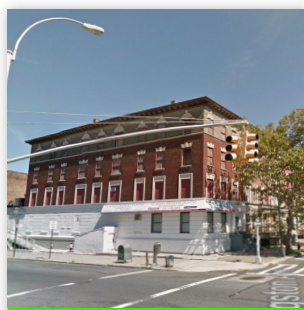
907 SAINT MARKS AVE
